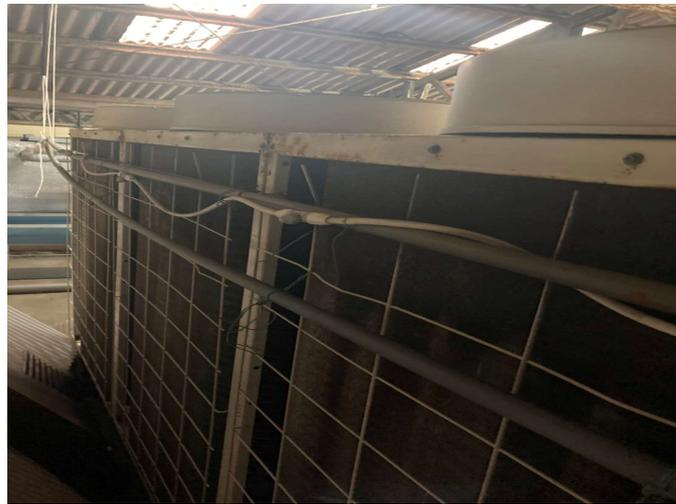
クーリングタワーの放熱フィンにミストシャワーの配管を取り付けて節電効果
